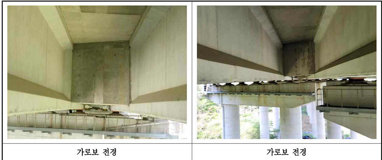
【사진 40.3.6】 가로보 전경
