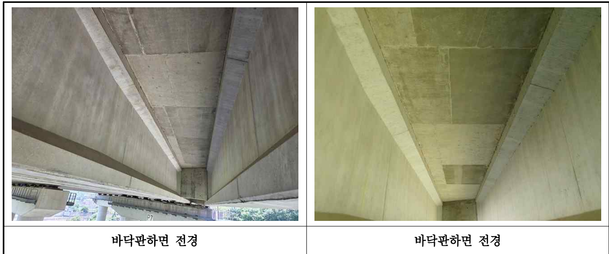
【사진 40.3.2】 바닥판하면 전경
