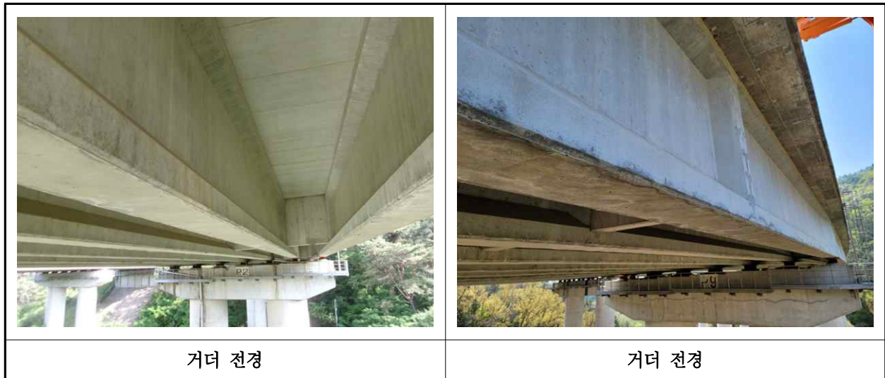
【사진 40.3.4】 거더 전경
