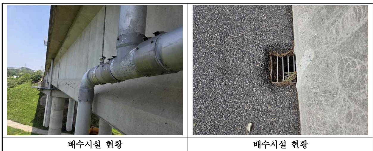
【사진 40.3.22】 배수시설 전경
