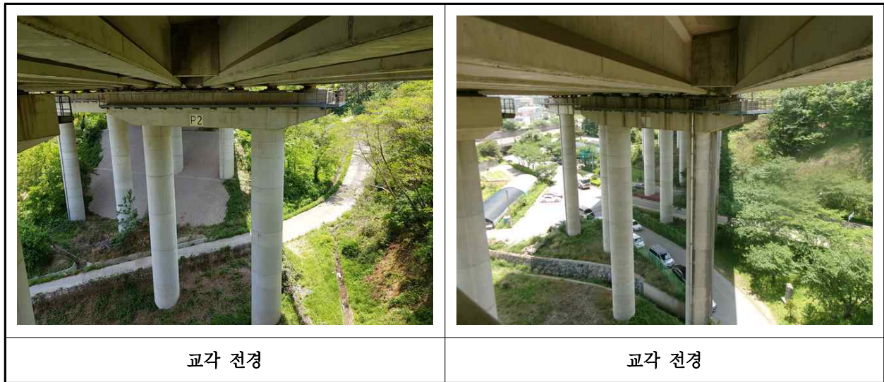
【사진 40.3.10】 교각 전경
