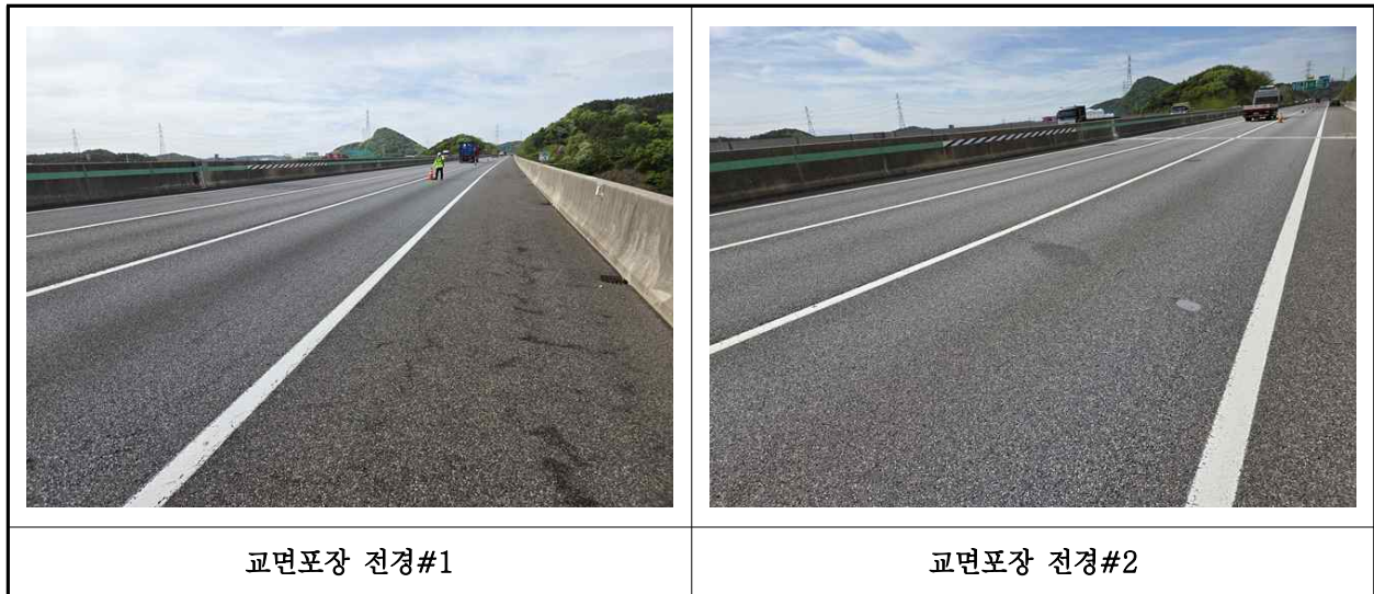
【사진 40.3.20】 교면포장 전경
