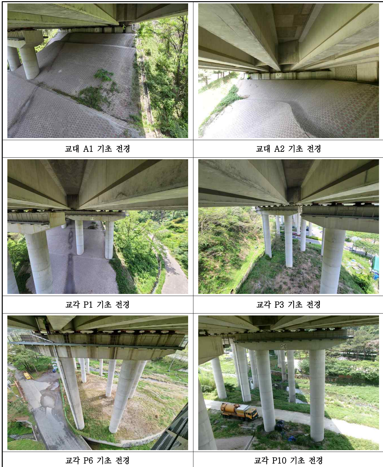
【사진 40.3.12】 기초 전경
