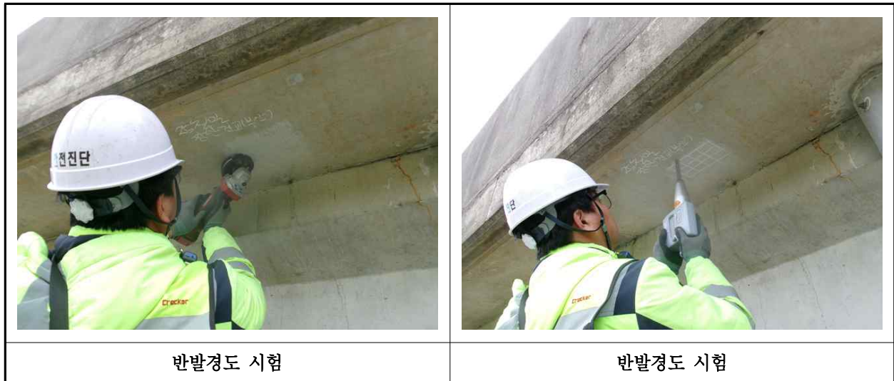
【사진 40.4.2】 반발경도시험 현장사진
