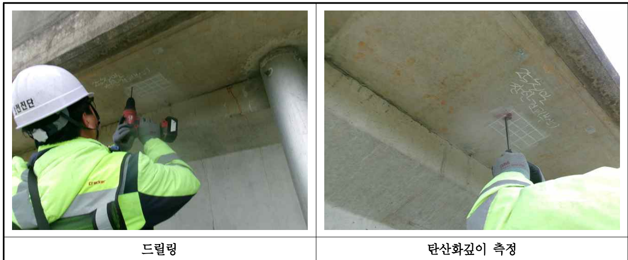
【사진 40.4.3】 탄산화 깊이 측정 현장사진
