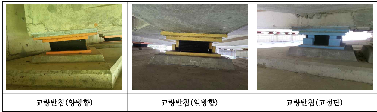
【사진 40.3.13】 교량받침 전경
