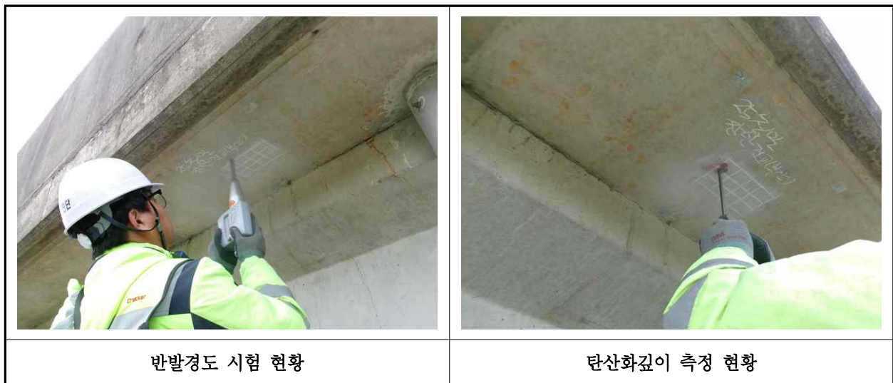
【사진 40.4.1】 콘크리트 내구성조사 현황
