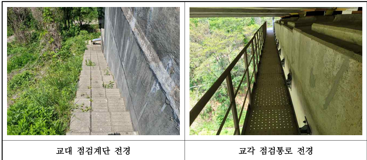
【사진 40.3.26】 교량 점검시설 전경
