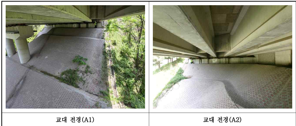
【사진 40.3.8】 교대 전경
