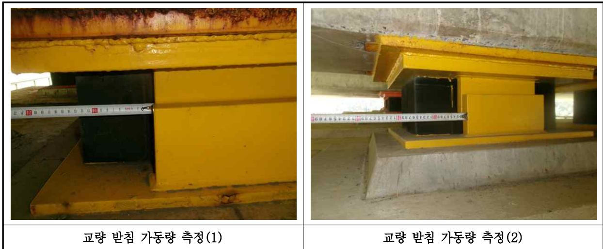
【사진 40.3.16】 교량받침 이동량 측정
